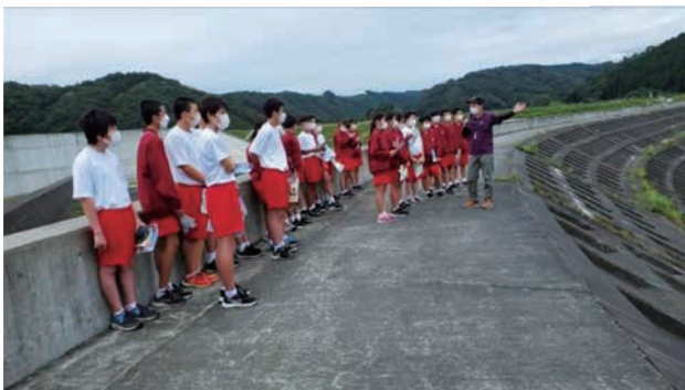
防潮堤から海を見る様子
