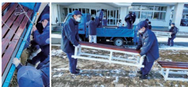
【修繕したベンチの搬入】
