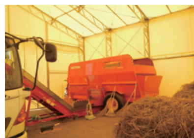
前処理施設（裁断機）の整備
