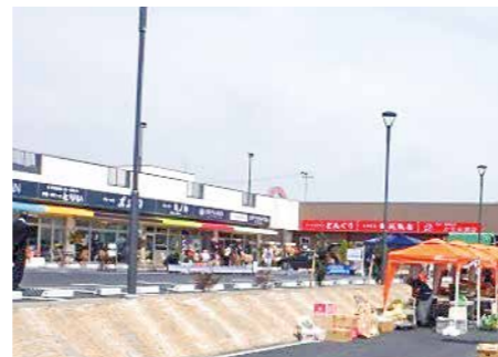
グループ補助金により再開した商業施設【大船渡市】
