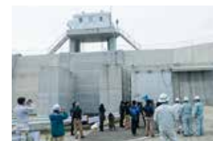
大船渡市合足農地海岸試運転の様子(平成29年4月27日)
