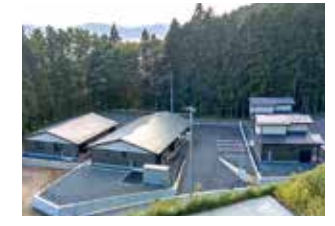
大槌町安渡地区災害公営住宅(平成30年12月完成)
