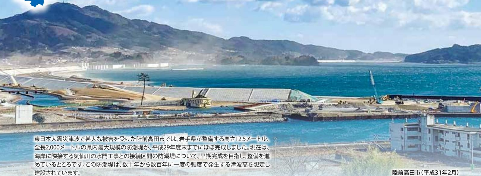
東日本大震災津波で甚大な被害を受けた陸前高田市では、岩手県が整備する高さ12.5メートル、全長2,000メートルの県内最大規模の防潮堤が、平成29年度末までにほぼ完成しました。現在は、海岸に隣接する気仙川の水門工事との接続区間の防潮堤について、早期完成を目指し、整備を進めているところです。この防潮堤は、数十年から数百年に一度の頻度で発生する津波高を想定し建設されています。
