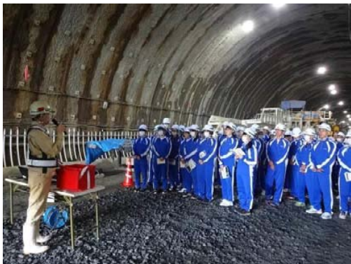
〈復興道路のトンネル建設現場見学〉
