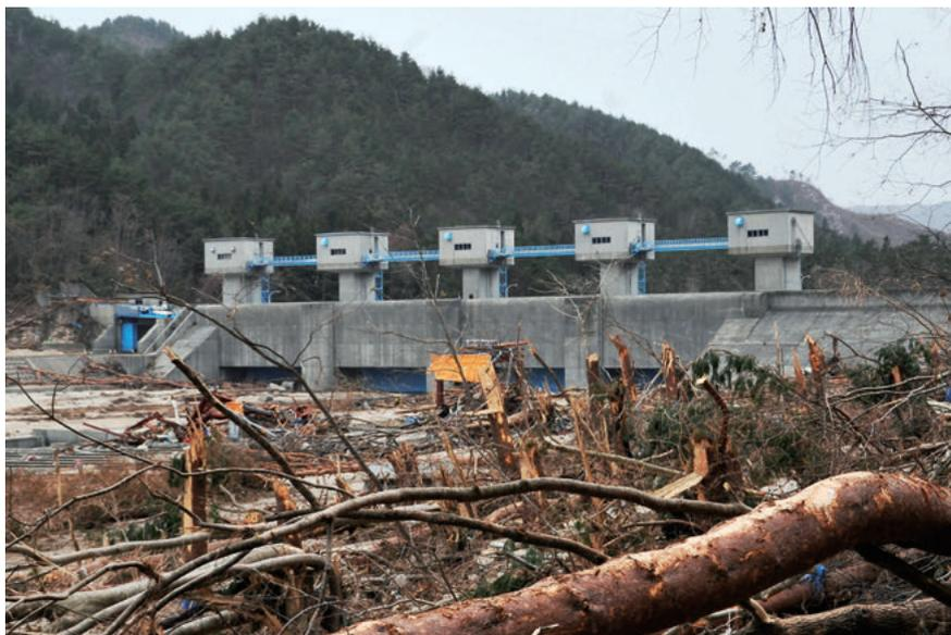
津波の威力で破損しながらも、普代地区の津波被害を最小限に抑えた高さ15.5mの普代水門
