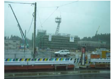
建設中の陸前高田市消防署
