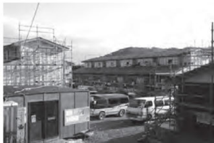
工事中写真（木造D・E棟）
