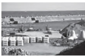
小本港の工事（平成25年12月撮影）
