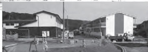
完成間近のA棟、B棟
