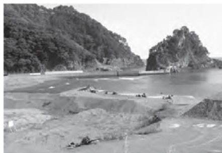
導流堤復旧工事(平成25年9月撮影)
