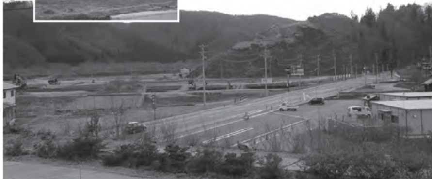
小本駅から見た集団移転地（西工区）（平成25年12月撮影）
