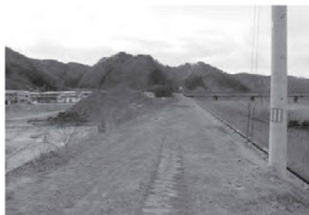
河川堤防のかさ上げ工事(小本川右岸)(平成26年1月撮影※)
