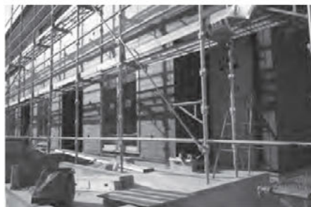
工事中写真（E棟玄関付近）
