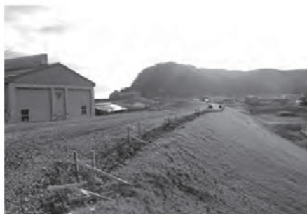
避難路工事(平成25年12月撮影)
