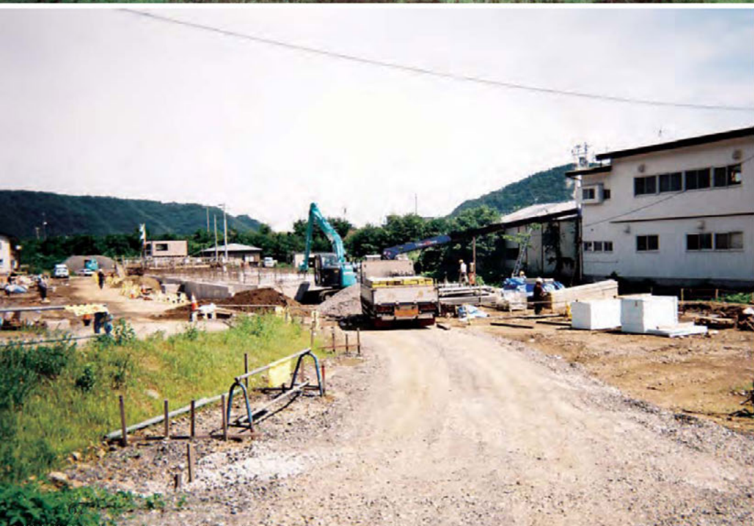
災害公営住宅建設中② 三浦烈一郎
