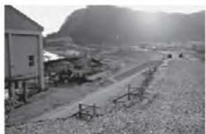
避難路工事（平成25年12月撮影）
