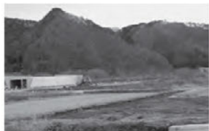
宅地造成工事（平成25年12月撮影）
