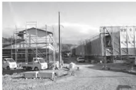
工事中写真（A・B棟）
