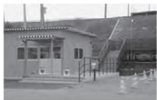
小本駅仮駅舎 (平成25年12月撮影)
