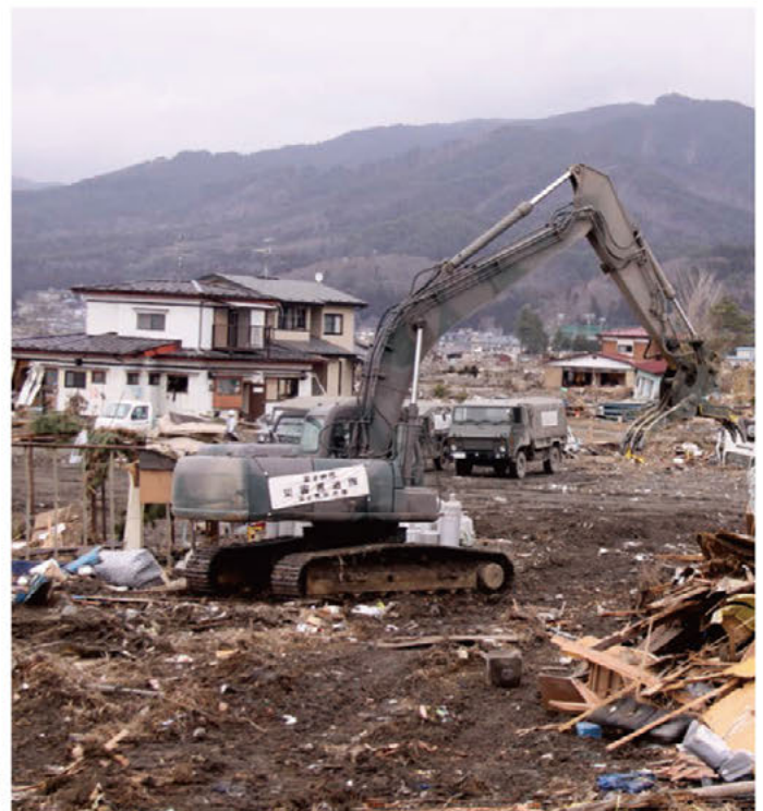
【国から家屋撤去の方針が示され急ピッチに作業を進める】
