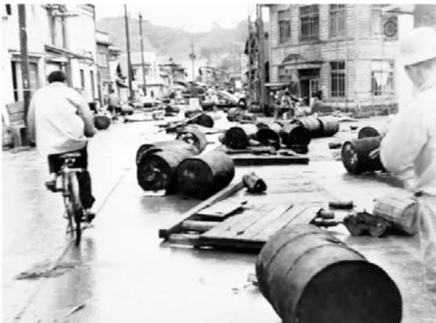
【写真 52】（鋏ヶ崎港町交番前）路上に散乱したドラム 缶【宮古測候所】
