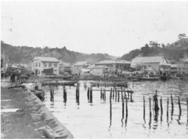
【写真 32】 宮古町 鎌ヶ崎 海岸通岸壁の棧橋板敷きは流され杭だけが残った【箱石・久里】
