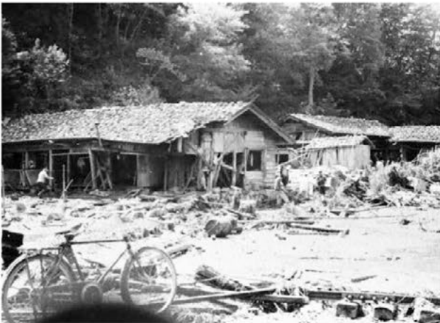
【写真 68】津軽石法の脇 家屋の被害【宮古測候所】
