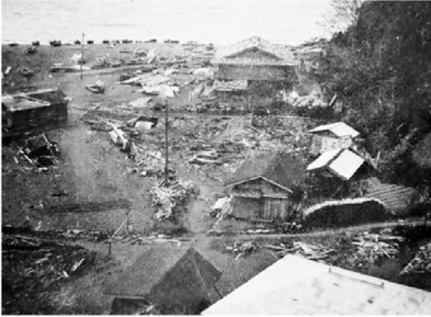
【写真 44】重茂村音部 流失を免れた海浜砂丘裏の家屋 [東京帝国大学地震研究所]
