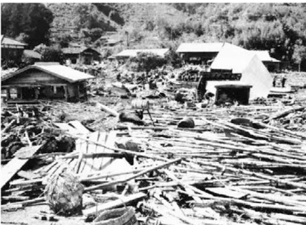
【写真62】高浜 中心地の惨状【宮古測候所】
