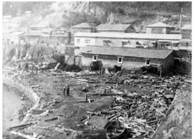
【写真 35】 宮古町 宮古測候所（現在の漁協ビル）付近、倉庫の流失【中央気象台】
