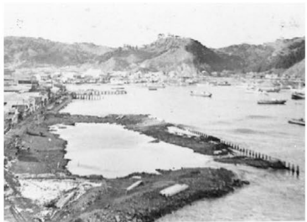
【写真 33】 宮古町 鎌ヶ崎上町 海岸通は（出崎埠頭）埋立て工事のため、人家の被害を少なからしめた【箱石・久里】
