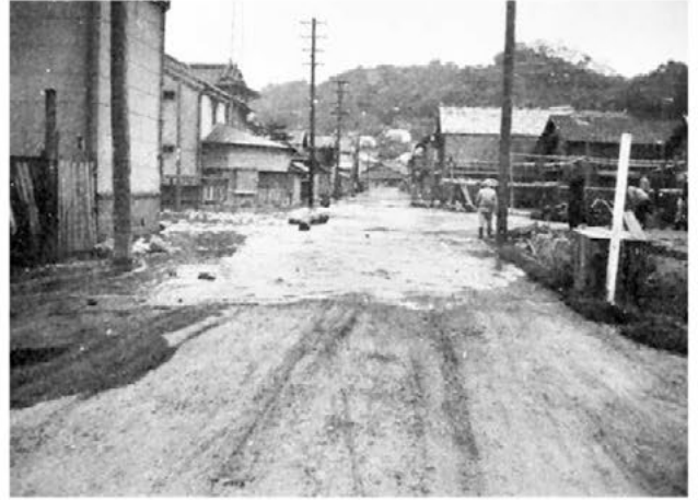
【写真 49】前須賀（鋏ヶ崎港町）浸水状況【宮古測候所】
