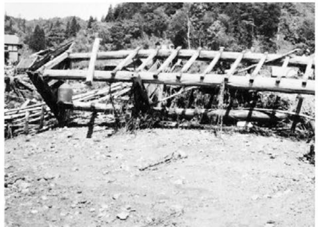
【写真63】高浜（倒壊した火の見櫓、江山寺付近）【宮古測候所】
