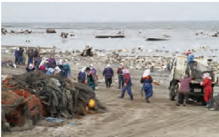
種市漁港海岸部でのガレキ片付け作業(H23.3.22)
