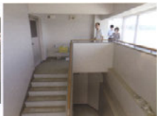
階段最上部の風除室 右手が海側（後日）
