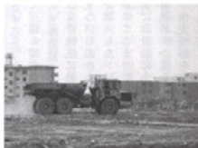
平成23年6月21日 工事風景
