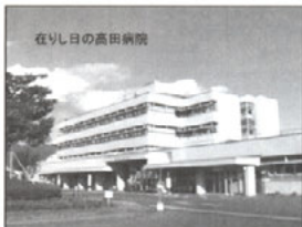
(図2) 在りし日(被災前)の高田病院全景
