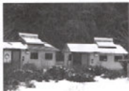
平成24年2月6日 住田仮設
