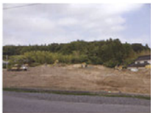
H23. 6. 13 高田病院仮設の工事はじまる
