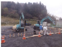
H23. 11. 28 病棟工事
