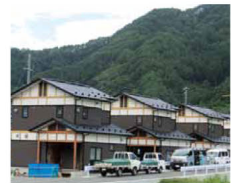
建設中の災害公営住宅(大槌町 平成26年9月)
