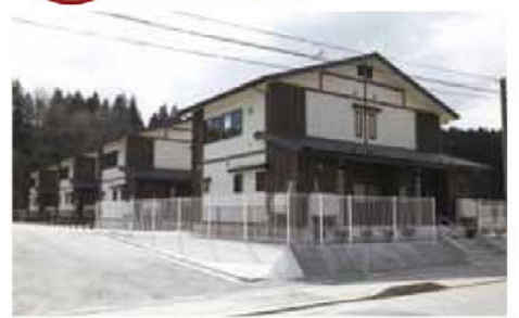
野田村門前小路第1災害公営住宅(平成25年3月25日完成)
