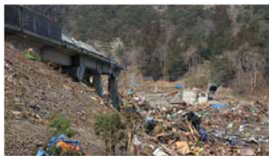
津波により線路が流失 (田野畑村 平成23年3月)
