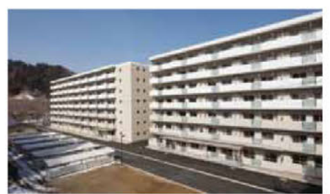
釜石市平田地区災害公営住宅(平成26年1月24日完成)
