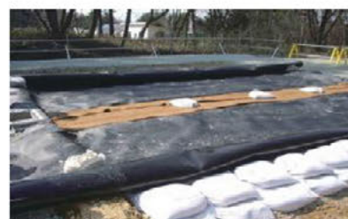
道路側溝汚泥一時保管場所(奥州市)
