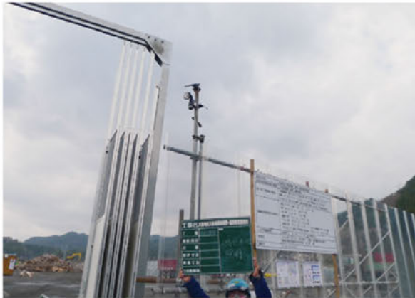
写真 3.17.2 不法投棄対策としての人感センサー照明（大槌地区、右：拡大）
