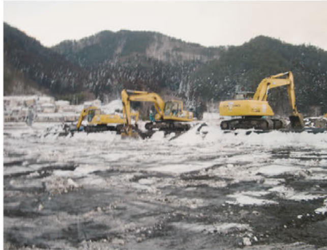
写真 3.17.3 二次仮置場での除雪作業（大槌地区）
