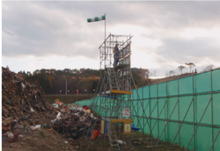
写真 3.5.5 監視台及び吹流し（列車見張員の配置、風向と風速の測定）
