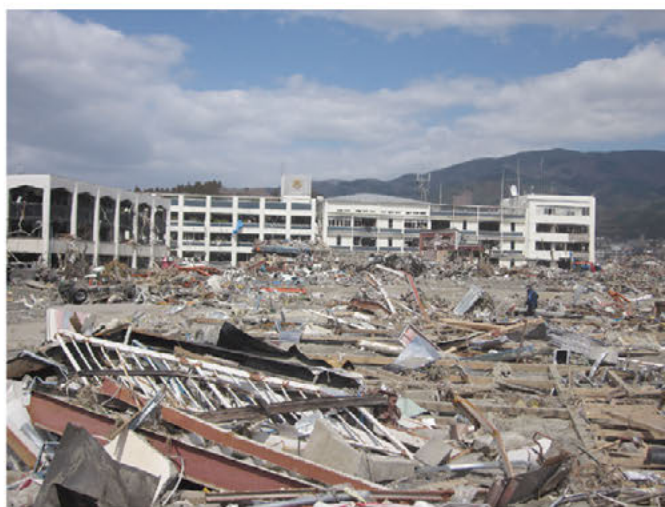
写真 3.2.1 被災した陸前高田市役所（陸前高田市提供）
