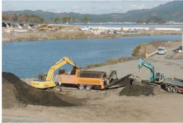
写真 3.5.3 分別土B種の製造状況（山田地区）
