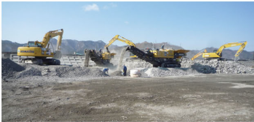
写真 3.5.4 コンクリートがらの破碎状況（大槌地区）
