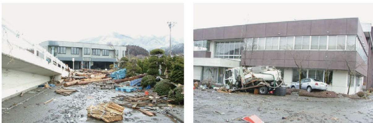
写真 2.2.1 気仙広域連合衛生センター（被災直後）
