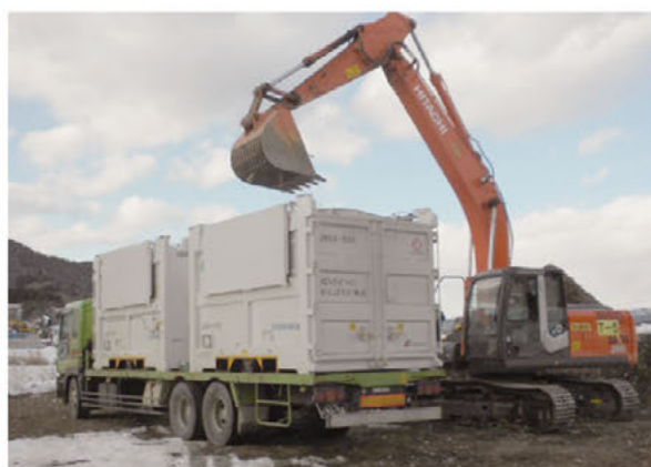
写真 3. 15. 1 広域処理で柱材・角材、可燃物の搬出に使用したコンテナ
