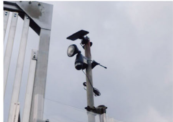
写真 3.17.2 不法投棄対策としての人感センサー照明（大槌地区、右：拡大）
