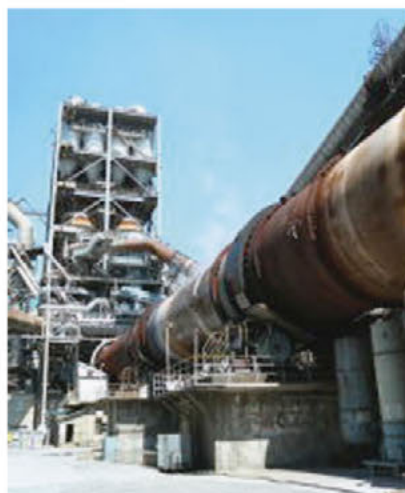
写真3.7.1 セメント焼成キルン
