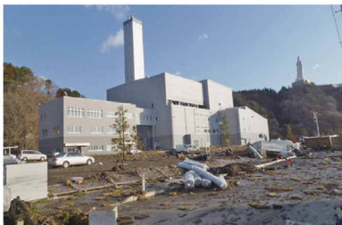
写真 2.2.2 岩手沿岸南部クリーンセンター（被災直後）
