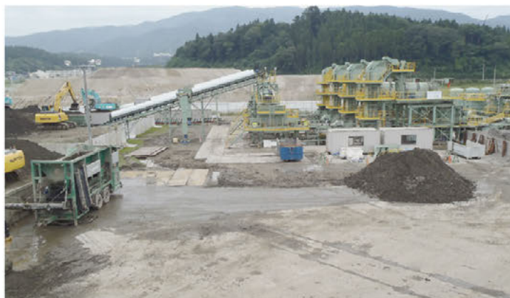
写真 3.5.13 土壌分級処理施設 (陸前高田市提供)
