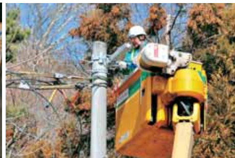
電気の復旧に向けて懸命に作業（3月19日）
