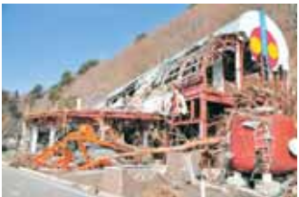
全壊した地下水族科学館もぐらんど
