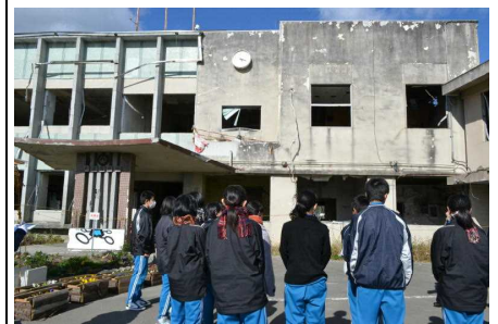
<役場の被災状況を知る>
