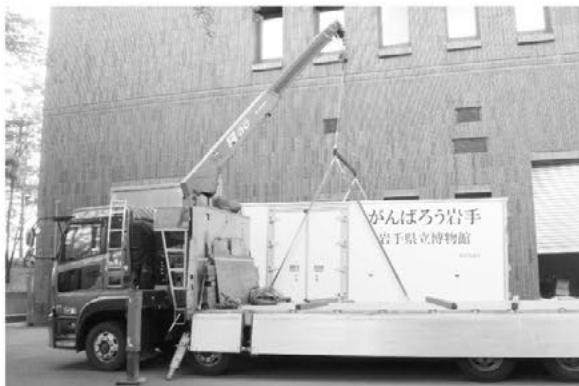
写真3-32 大型冷凍庫の設置作業
